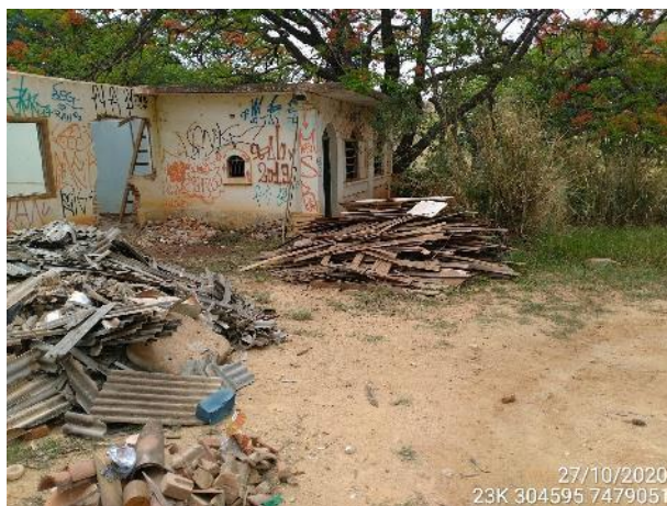
Foto 11 – Execução da segregação do material na Casa 28, Lote 31, onde foi identificado material de amianto. 27/10/2020.
