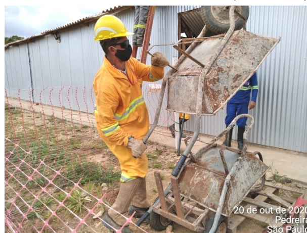
Foto 4 – Organização área do Canteiro Industrial. Data: (20/10/2020)
