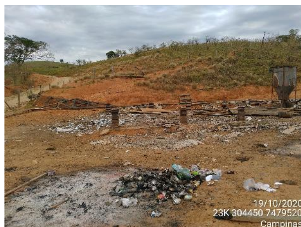
Foto 6 – Vistoria de pré-demolição da Casa 19, Lote 08, Fazenda Palmares. 19/10/2020.
