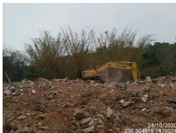
Foto 8 – Demolição da Casa 29, Lote 31. 24/10/2020.
