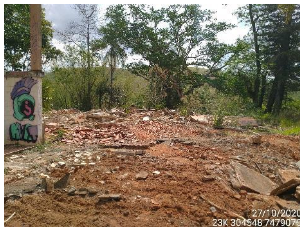
Foto 12 – Demolição na Casa 25, Lote 31. 27/10/2020.
