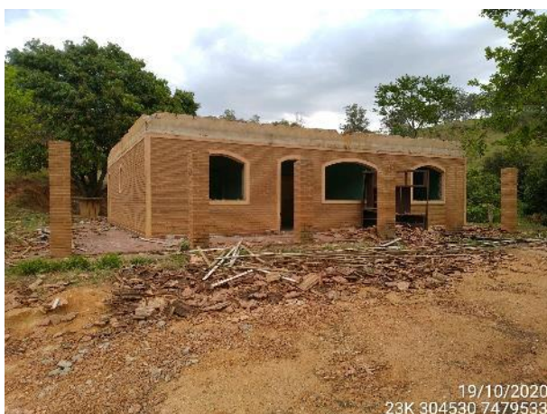
Foto 5 – Vistoria de pré-demolição da Casa 18, Lote 08, Fazenda Palmares. 19/10/2020.
