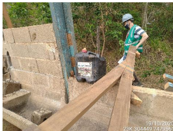
Foto 4 – Na Casa 17 foi identificado produto químico, que exige segregação e destinação específica. 19/10/2020.
