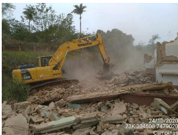
Foto 7 – Demolição da Casa 29, Lote 31. 24/10/2020.
